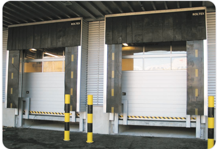
Teräskudosvahvistetut sivuelementit kovaan käyttöön.
